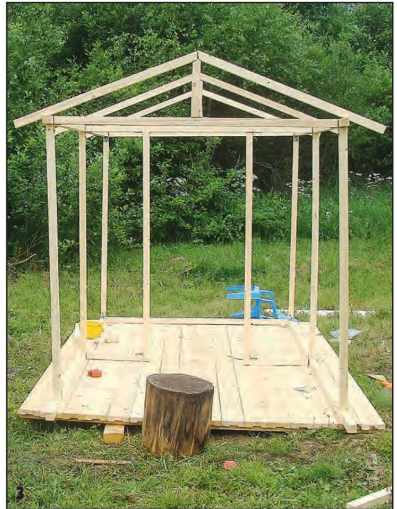
Каркас домика собран из брусков сечением 45х45 мм.
