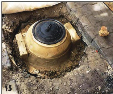
Место стыка купола с кирпичной кладкой тщательно замазал глиной.
