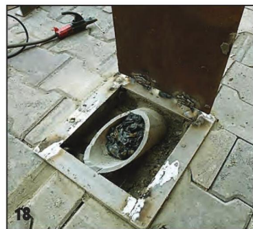
Лючок перекрывает доступ воздуха в тандыр во время топки и защищает трубу в промежутках между топками.
