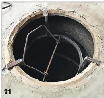
21 Чтобы крышка тандыра плотно ложилась на горловину, выпилил пазы под зацепы.
