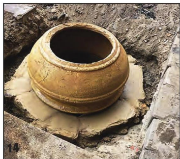
Чтобы выдержать высоту тандыра, под купол пришлось положить ещё один ряд кирпича плашмя.
