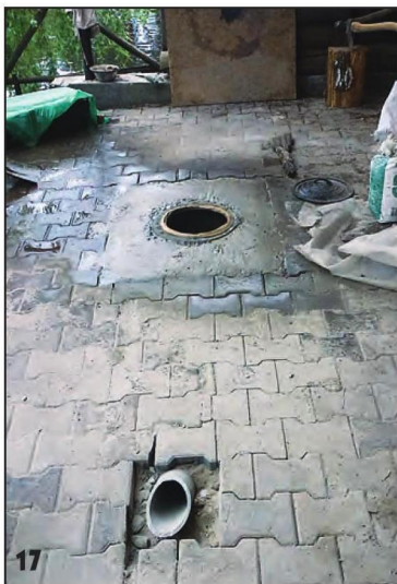
Поверх керамзитовой засыпки сделал цементную стяжку, а поддувальную трубу отпилил по уровню площадки.
