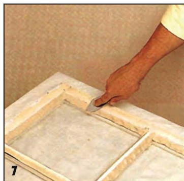
Для разравнивания замазки шпатель держат под углом 45° и проводят им вдоль ребра фальца.
