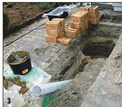
Асбоцементную трубу установил под углом 45° к поверхности земли.
