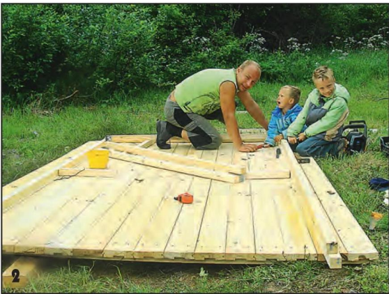
Основой для домика служит щит, сбитый из половых досок.
