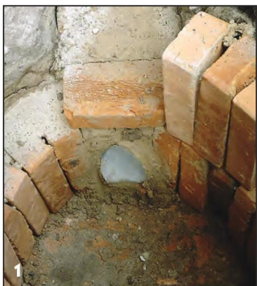
На уровне первого ряда установлен нижний конец асбоцементной трубы, по которой к месту горения будет поступать воздух.
