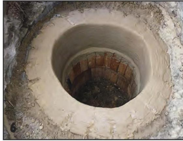
Последний ряд кирпичей изнутри и сверху обмазал глиной.
