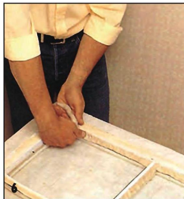
Из замазки скатывают тонкий жгут и укладывают его по краям стекла.
