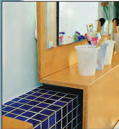
Привлекательный проект, продуманные детали: теньевые швы позволяют элементам словно парить над мозаикой (фото слева). Стеклянная полка фиксируется маленькими держателями (фото внизу).
