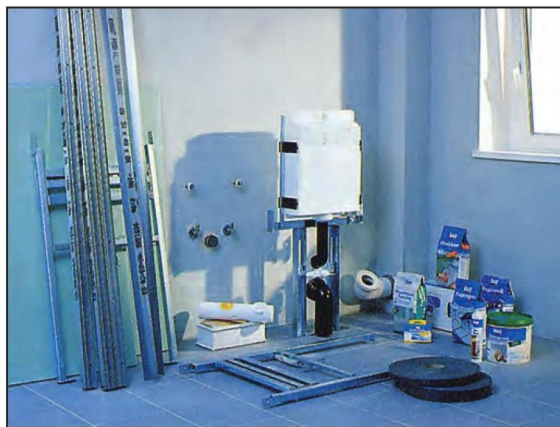
Материалы для монтажа: рамы для умывальника и унитаза, металлические профили, изоляционная лента, клей для плитки, затирка для швов, грунтовка.
