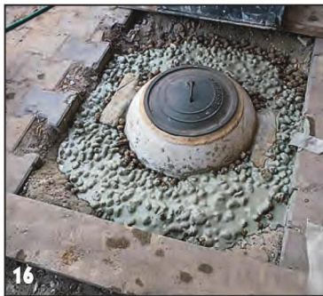
Пространство вокруг купола засыпал керамзитом и залил его цементным молочком.
