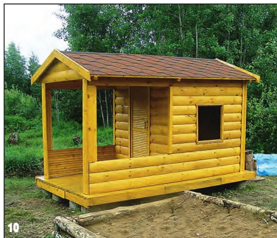
В последнюю очередь домик был поднят на фундамент из чурбаков, а по краю щита сделана декоративная «юбка».
