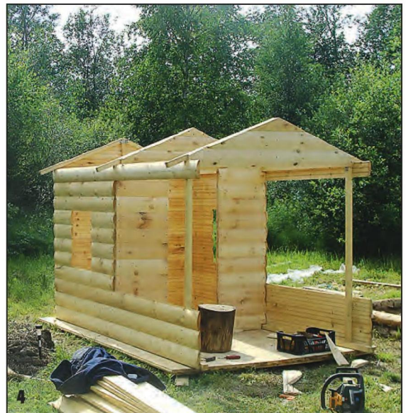
Домик обшит блокхаусом, который придаёт ему внешнее сходство с бревенчатой избушкой.
