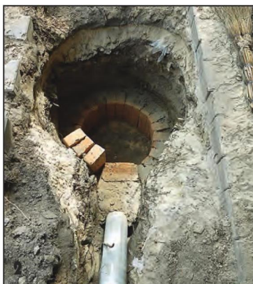
На уровне первого ряда установлен нижний конец асбоцементной трубы, по которой к месту горения будет поступать воздух.
