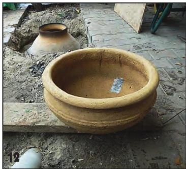
По плану «Б» в качестве купола решено было использовать вазу из шамотной глины.
