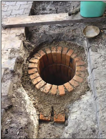
5 Наружные швы кирпичной кладки заполнил сухой глиной.
