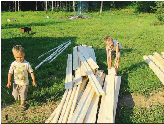
Стройматериалы завезены — пора приниматься за работу!
