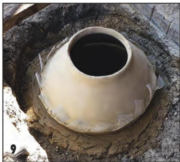
Просушенный купол занял своё место. Купол для прочности армирован сеткой из стекловолокна.
