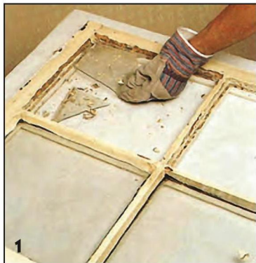
1 Вокруг повреждённого стекла удаляют старую замазку, выдёргивают штифты (мелкие гвозди без шляпок) и вынимают осколки стекла из переплётa.
