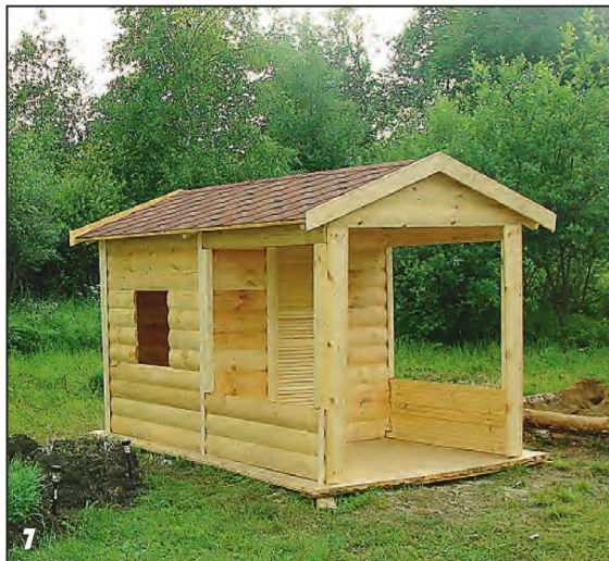
7 Всё, как на настоящем доме: уложена кровля из мягкой черепицы, установлены ветровые доски, навешена дверь. Домик готов к покраске.
