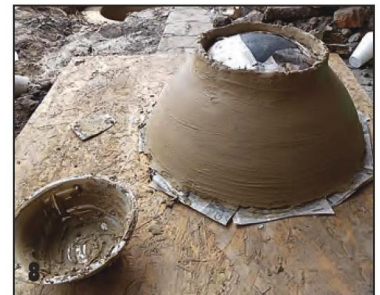
7 Чугунный котёл стал отличным шаблоном для изготовления купола тандыра из глины.
